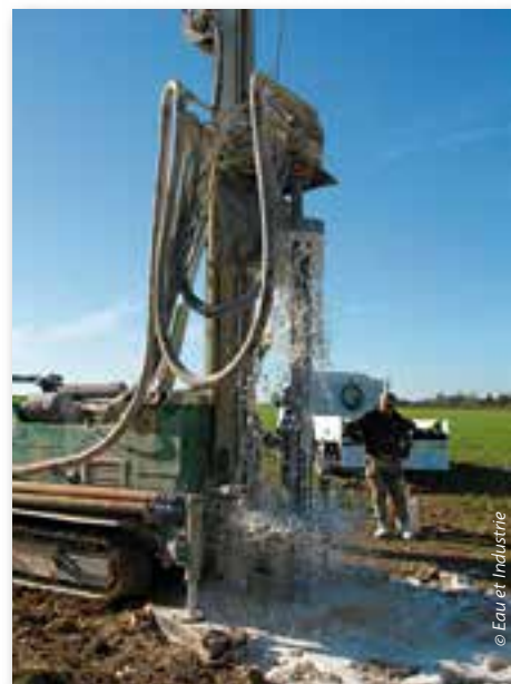
Travaux de sondage
